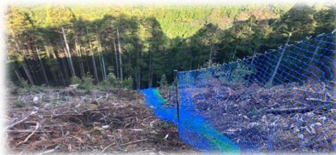
防獣ネット設置
