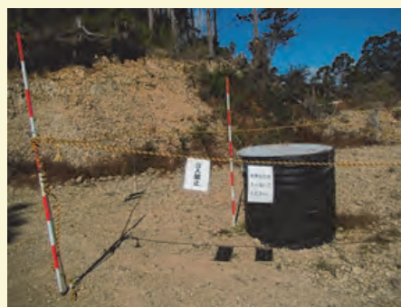
設置後の状況
