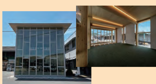
ウッドテクノス新社屋 (高知県高知市、令和6(2024)年5月竣工) GIR接合の1方向ラーメンにより開放的な空間を実現した、ヒノキ集成材を用いた低層木造ビル
