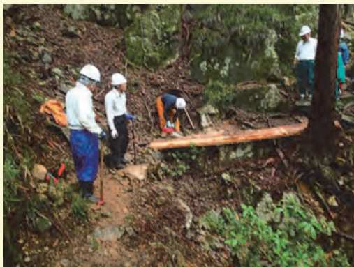
丸太橋架替えの様子
