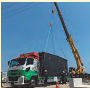
左：トラックからモクタスキューブを下ろす様子 右：輪島塗仮設工房の内装
