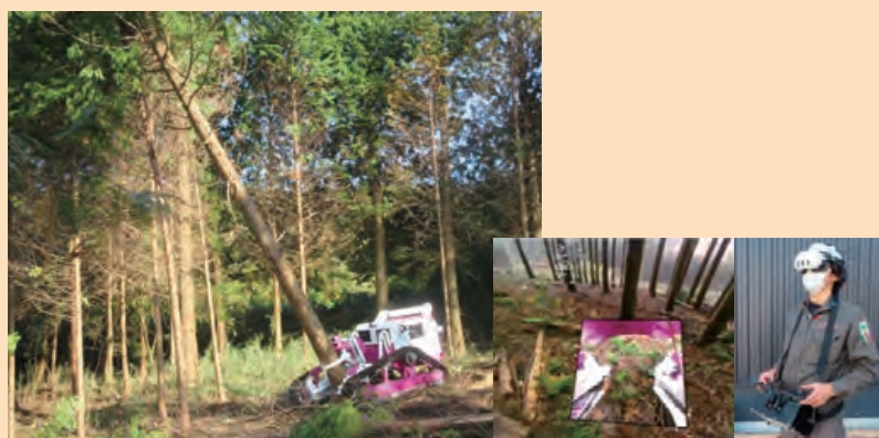
遠隔操作伐倒機械による伐倒の様子
