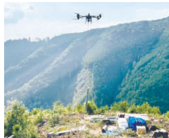
ドローンを活用した資材運搬
