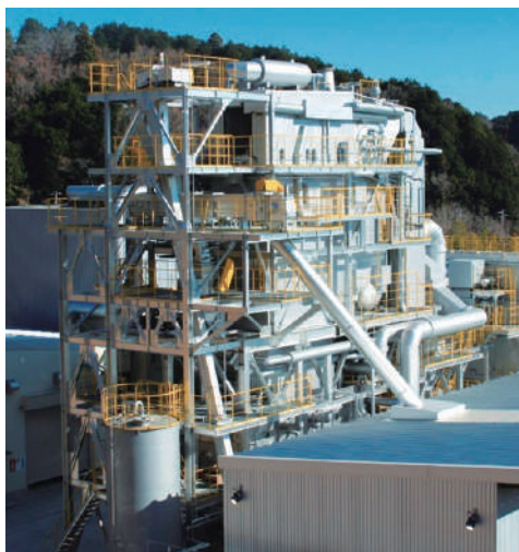
松阪木質バイオマス発電所の2号機
