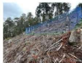
下の写真：D区のやや右下から全体の写真
