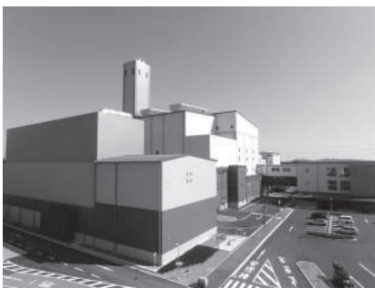
四日市市クリーンセンター
