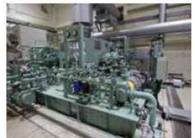
蒸気タービン・発電機 ボイラーから発生した蒸気を利用して発電を行います。
