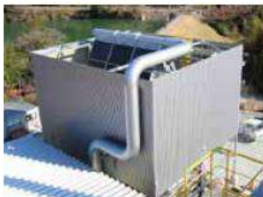
蒸気復水器 タービン排気をファンで冷却し水に戻します。
