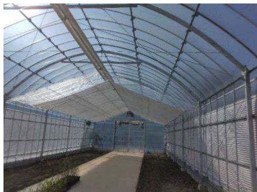
新設ビニールハウス
