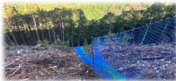
防獣ネット設置
