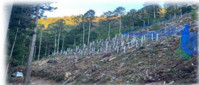
ヘキサチューブ設置
