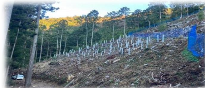
ヘキサチューブ設置
