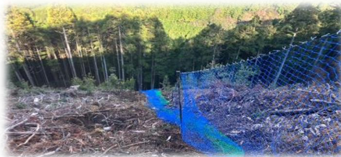
防獣ネット設置
