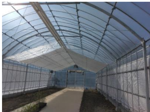
新設ビニールハウス
