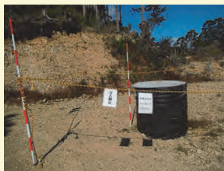
設置後の状況
