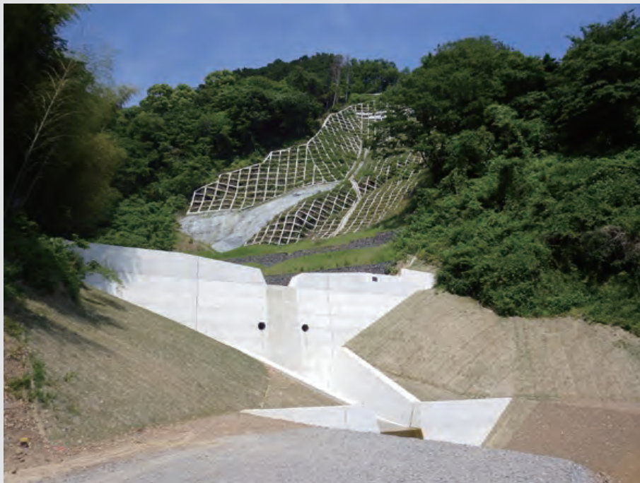
山腹工及び谷止工による崩壊地の復旧(愛媛県宇和島市)
