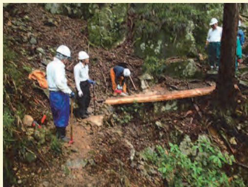
丸太橋架替えの様子
