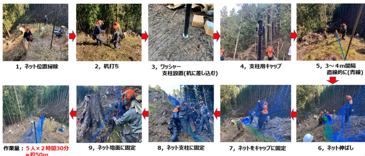
防獣ネット施工作業 一連の流れと、作業時間の目安
