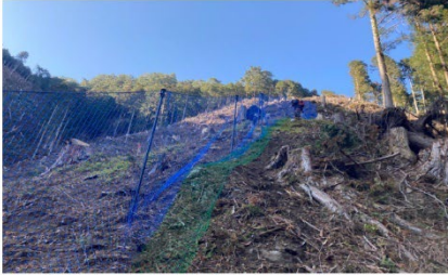
※防獣ネット(ステンレス入り、スカート付) 多数の支柱で支持し、保護したい箇所を囲う 複数の苗木を守り、横に広がる広葉樹にも使用可能
