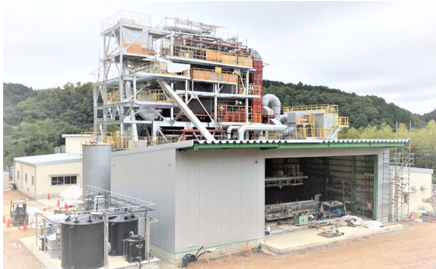
直近の現場映像。架構のサイズは6MW級とさほど変わらない(写真:BPT社提供)
